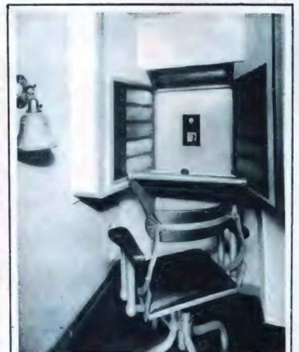
Wenn man auf dem Stuhl Platz nimmt, sieht man auf der Mattscheibe vor sich die Person, mit der man das Ferngespräch führt. Rechts, links und oberhalb des Sprechenden die Photozellen.
